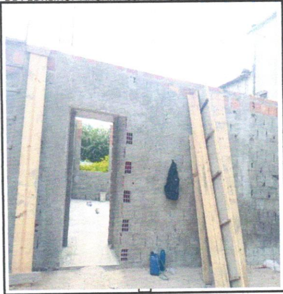
FOTO 15- CHAPISCO APLICADO EM ALVENARIAS E ESTRUTURAS DE CONCRETO INTERNAS, COM COLHER DE PEDREIRO. ARGAMASSA TRAÇO 1:3
